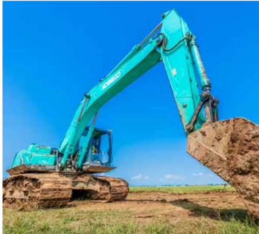
Progress Pembangunan Bandara Tahap 1 A - Paket 1 (25 Februari 2015)
