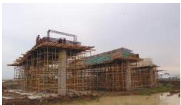
**Proses Pembangunan Kolom Ramp Simpang Susun dan Pengecoran Pier Head Ramp Simpang Susun**
