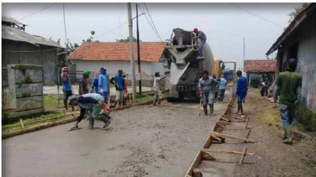
Perbaikan Jalan / Road Repair
